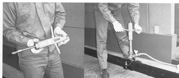
(4) コアの取付け
