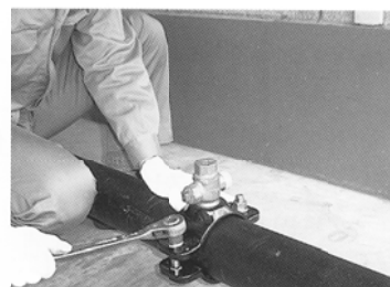
(2) サドル付分水栓の取付け
