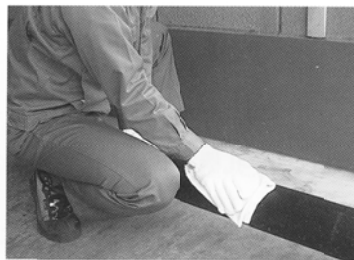
(1) 配水管の清掃
