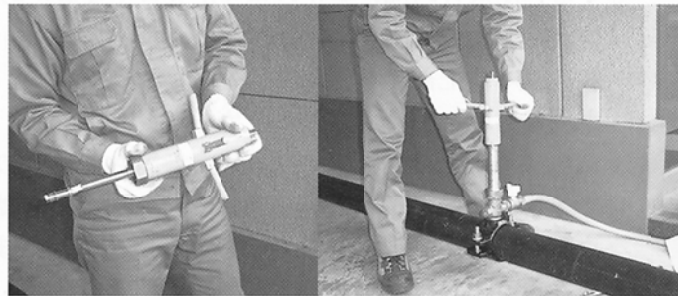
(4) コアの取付け
