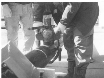
(1) 穿孔機の取付け
