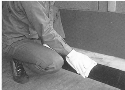
(1) 配水管の清掃
